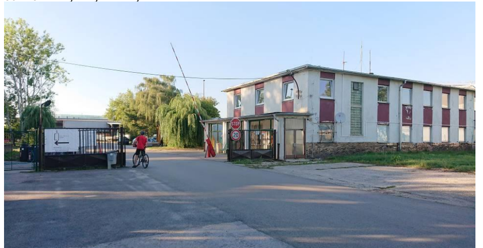
obr. 75 Priemyselný areál bývalá Prefa
