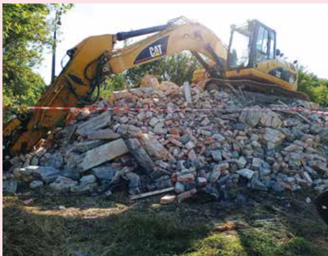
V časti Lahne Železnice SR zbúrali budovu bývalej železničnej stanice pre jej nevyhovujúci technický stav
