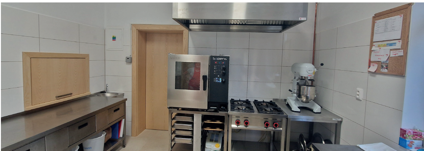
Zrekonštruovaná kuchyňa a oplotenie
