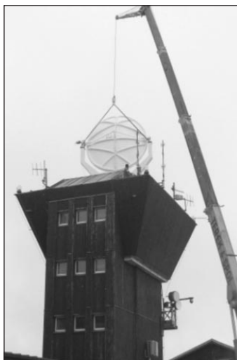
Pohľad na montáž nového meteorologického radaru na Kojšovskej holi.
